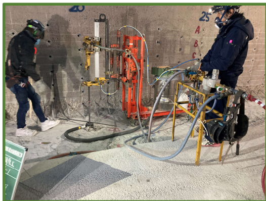
あと施工せん断補強工 （削孔工）
