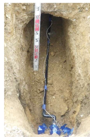
布設替え完了（遠景写真）
