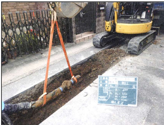
施工状況（既設管撤去工）
