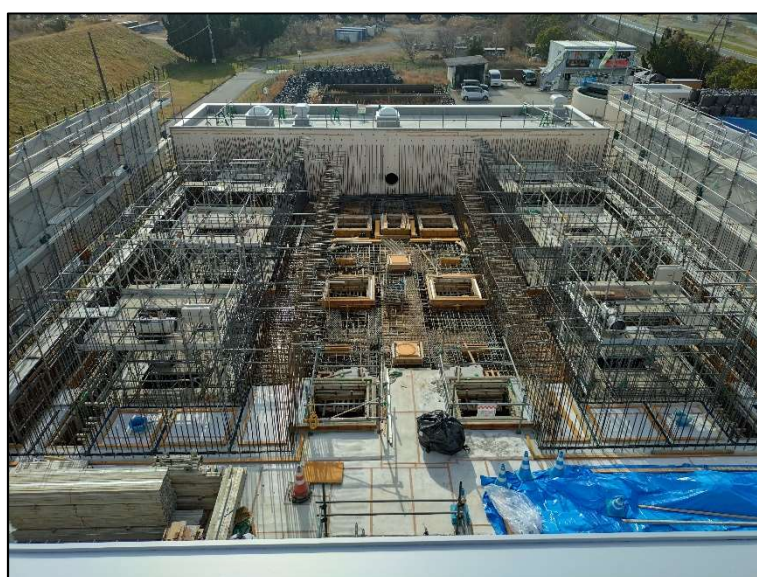
急速ろ過池築造状況 (躯体部鉄筋組立段階)
