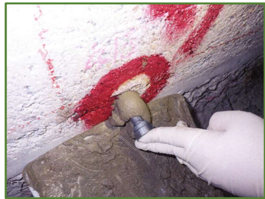
あと施工せん断補強工 （鉄筋挿入工）
