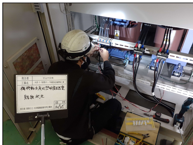
施工状況 2 結線状況
