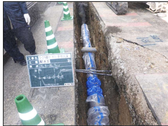
施工状況（新設管布設工）
