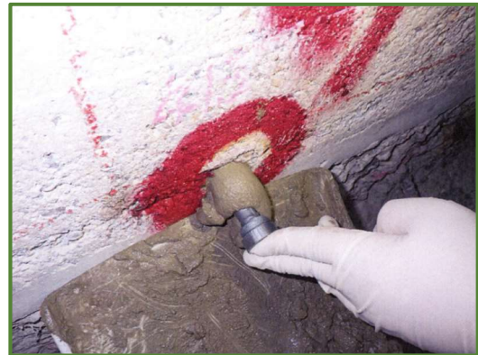
あと施工せん断補強工 （鉄筋挿入工）
