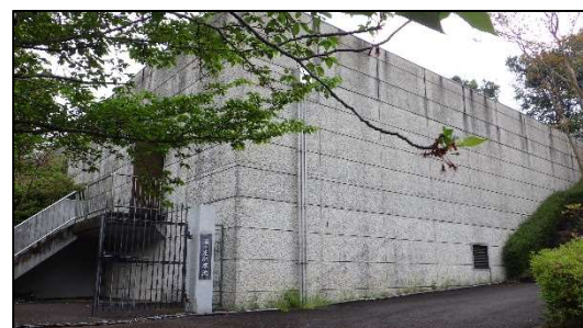
外観（五ヶ庄配水池）
