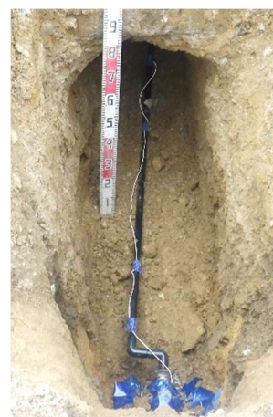
布設替え完了 （遠景写真）
