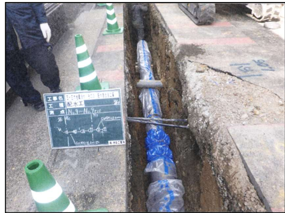
施工状況（新設管布設工）
