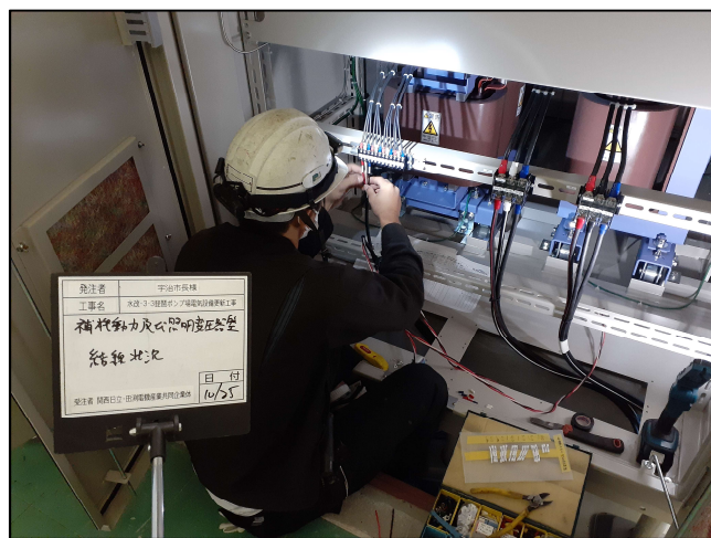
施工状況 2 結線状況
