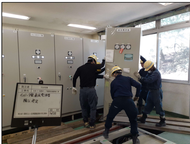
施工状況 1 基盤搬入状況
