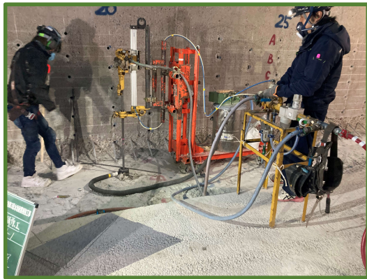
あと施工せん断補強工 （削孔工）
