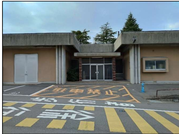
外観（琵琶ポンプ場）
