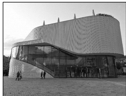
（写真 2） コンサートホール
