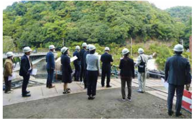
<実地調査：天ヶ瀬ダム崩落事故現場>
