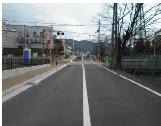
整備後 (令和5年3月)
