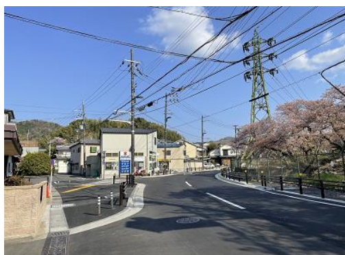
整備後 (令和5年3月)
