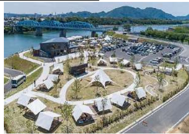
賑わい拠点の整備 (木曾川/美濃加茂市)
