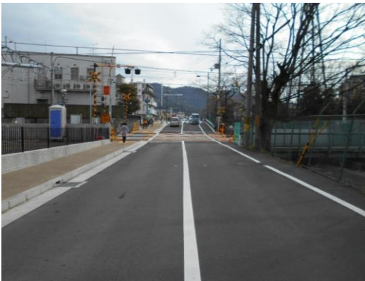
整備後（令和5年3月）
