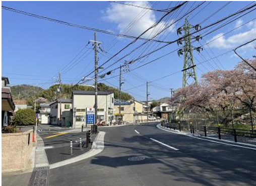
整備後（令和5年3月）
