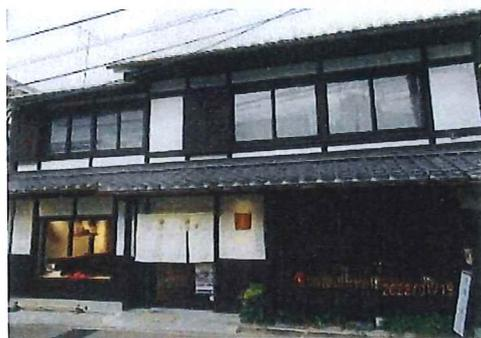
昭和6年に料理屋として建築され何度かの増改築を経ながら、昭和初期の宇治の町家の姿を今に残す貴重な建物である。切妻造平入りで、正面に出半間の下屋を設けた、立ちの高い2階建てで、軒はせがい造りである。建物正面は真壁造漆喰塗りで、妻面は杉板張りである。
