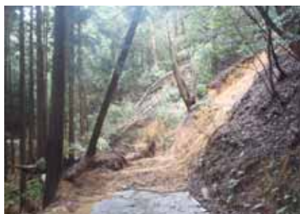
▲池尾での土砂崩れ
