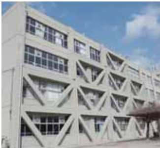
▶中学校の耐震補強
