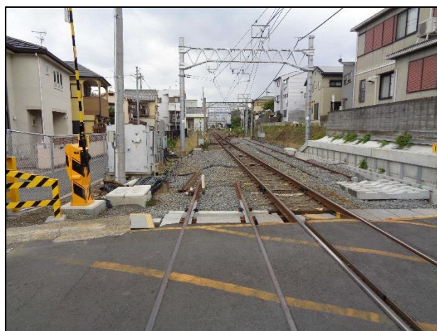
JR奈良線の高速化・複線化事業 （御陵道踏切・市道南山畑中村線）
