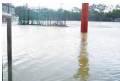
▲西宇治中学校グラウンドにて雨水を一時貯留している様子
