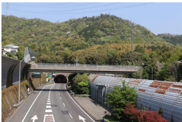
菟道上野跨道橋（羽戸山一丁目～菟道東集上り）
