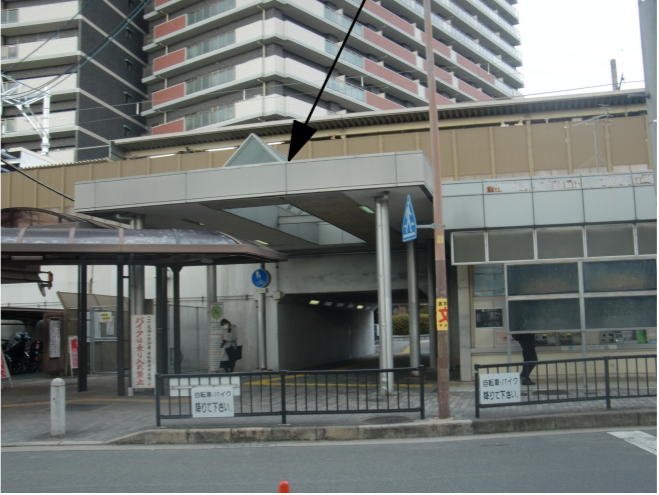
歩道用シェルター(上屋)撤去工事中
