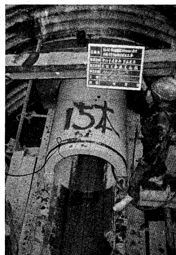
▲すすむ污水管布設工事(昨年1月木幡正中で)
