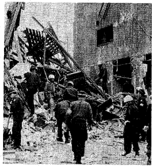
▲木幡ガス爆発現場(6月1日)
