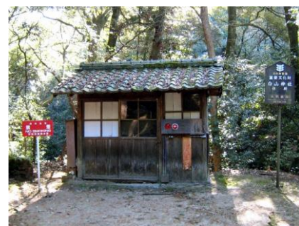
消防設備の設置（白山神社拝殿）
