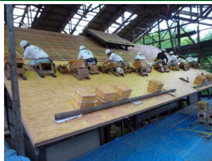
萬福寺松隠堂（重要文化財）の修理
