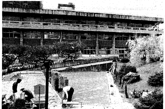
舗装工事がすすむ市役所前駐車場(15日)
