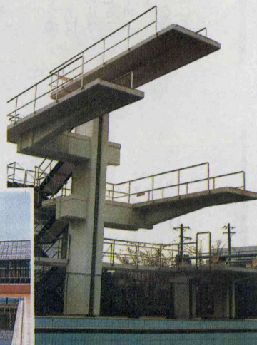
▲太陽が丘飛び込みプール 「片持ち梁(はり)式」飛び込み台。府下で唯一の飛び込みプール。
