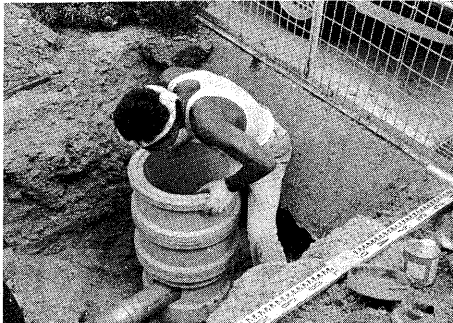
▲汚水ますの設置(8月26日木幡河原で)
