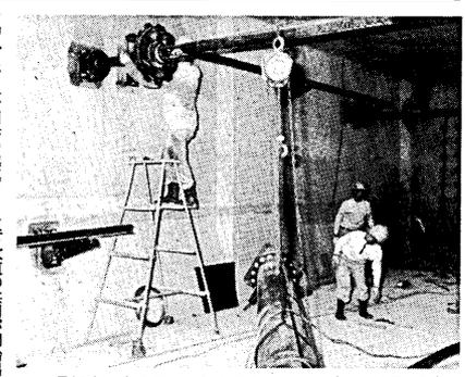
▲最初沈殿池での汚泥かき寄せ機の設置 (8月23日撮影)
