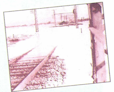
▲昭和28年9月25日の台風13号の被害で宇治 川が決壊。写真は、小倉町西山から望む近鉄 軌道で、中央は小倉駅の被害の状況。この災 害は典型的な雨型台風であった。
