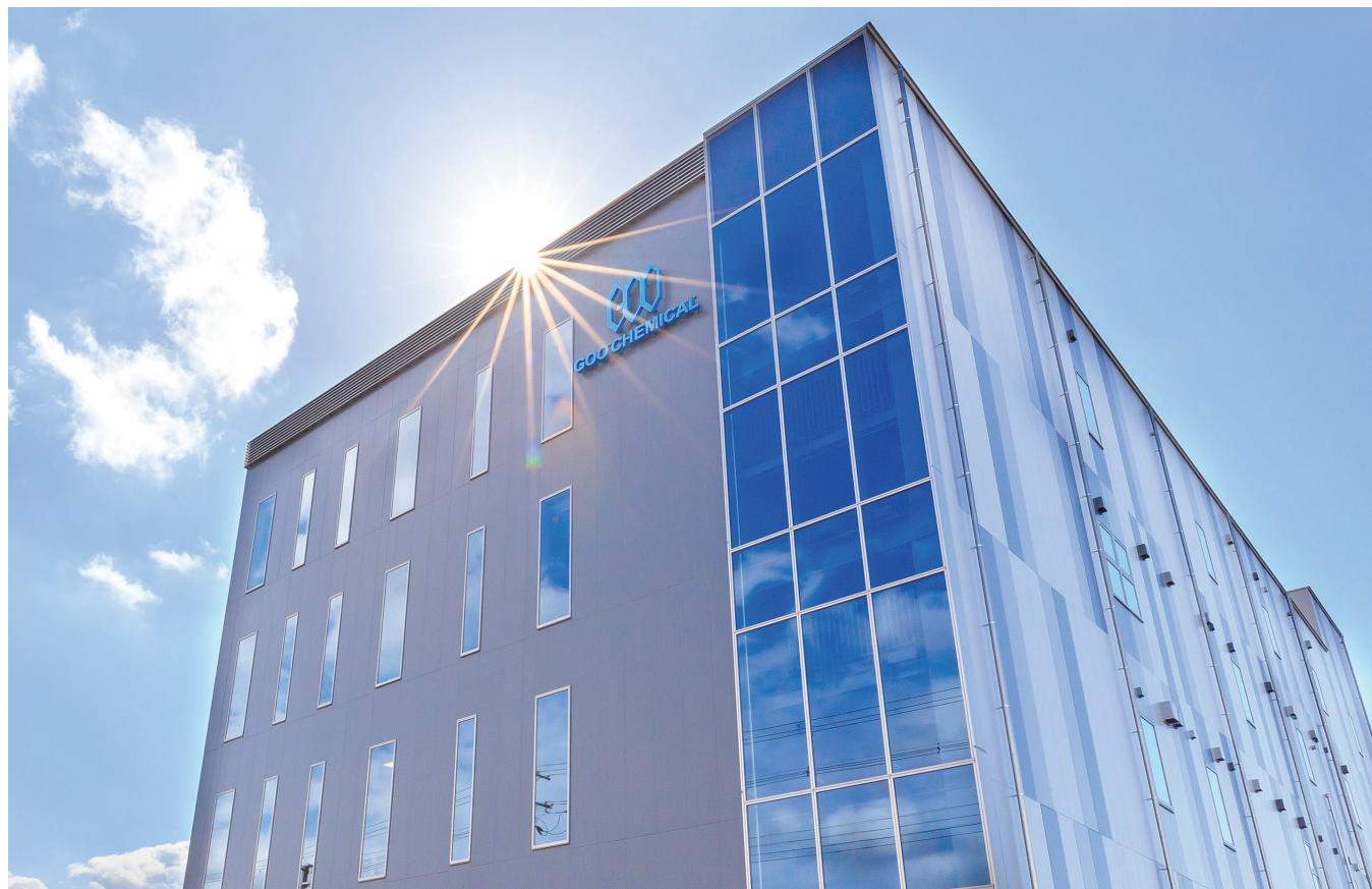
新本社研究棟外観
