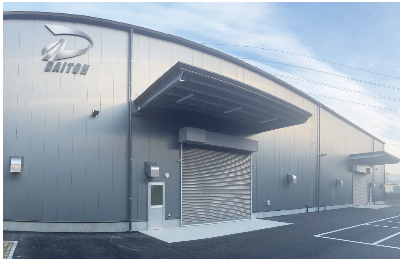
完成した組立工場
