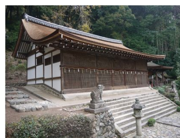
宇治上神社本殿の修理 H26.12
