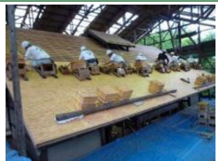
萬福寺松隠堂（重要文化財）の修理
