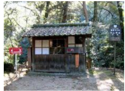
消防設備の設置(白山神社拝殿)
