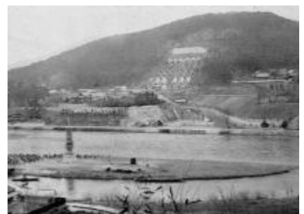
宇治川電気株式会社宇治発電所
