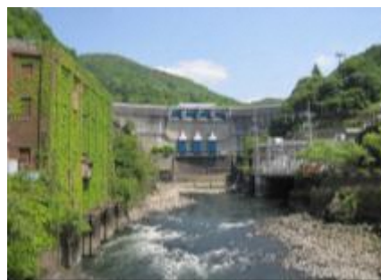
宇治川天ヶ瀬ダム
