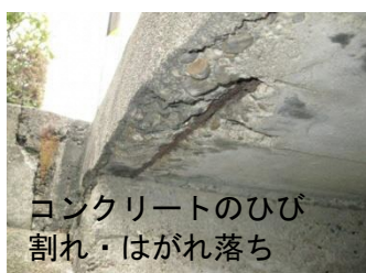
橋梁の損傷例
