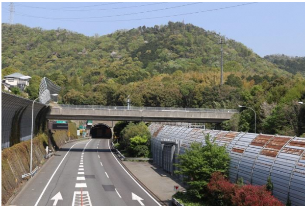
菟道上野跨道橋（羽戸山一丁目～菟道東車上り）
