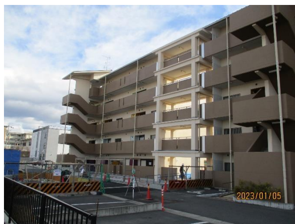
2期棟 北西より
