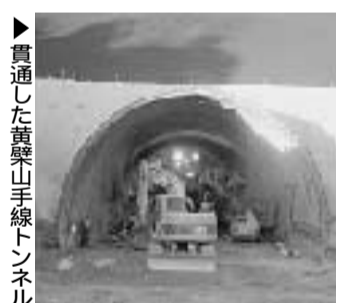
貫通した黄檗山手線トンネル
