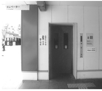
JR宇治駅エレベーター
