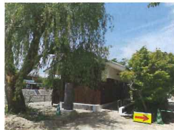
橋島のトイレ（改修後）
