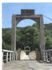
天ヶ瀬吊り橋（改修後）
