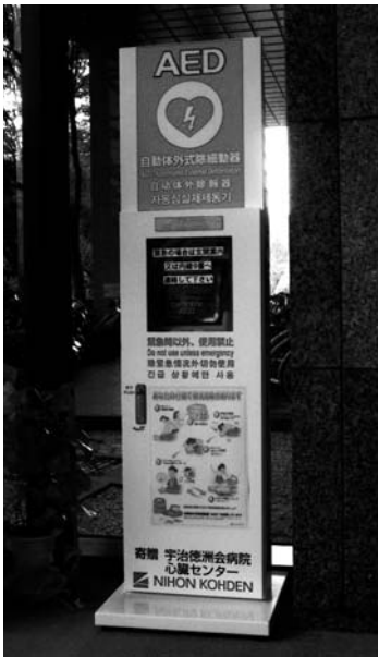
▲ 市役所1Fロビーに設置されているAED
