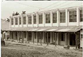
新築の校舎(上)と旧火薬製造所の建物を改造した校舎(下)
