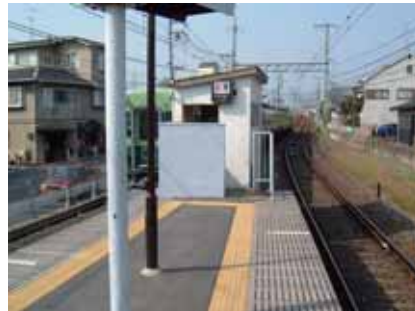
多機能トイレが整備されていない (京阪三室戸駅)
