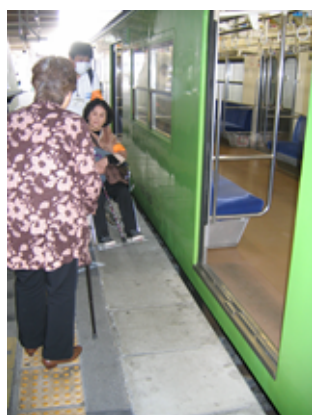
ホームと電車の間に段差がある (JR 宇治駅)
