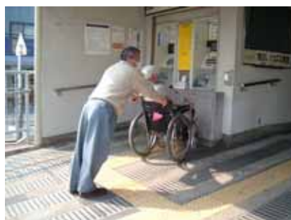
スロープが急である (京阪三室戸駅)
