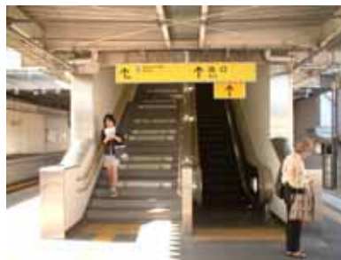
エスカレーター及び 視覚障害者誘導用ブロック
