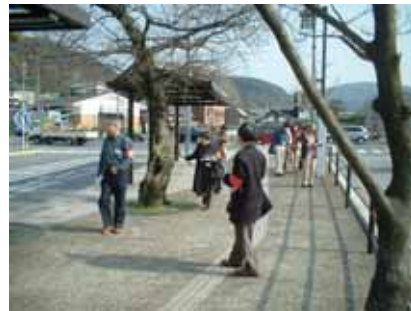
舗装と視覚障害者誘導用ブロックの 色がわかりづらい (京阪宇治駅前広場)
