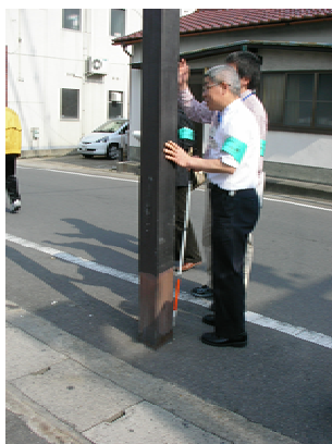
照明柱がはみ出している (府道宇治淀線)
