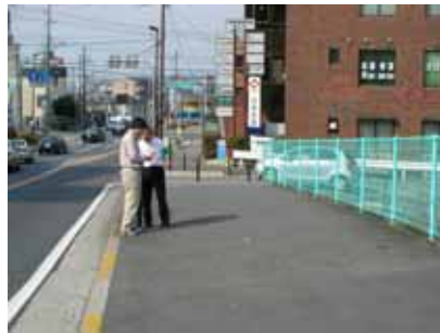
視覚障害者誘導用ブロックが 連続していない (市道宇治白川線)
