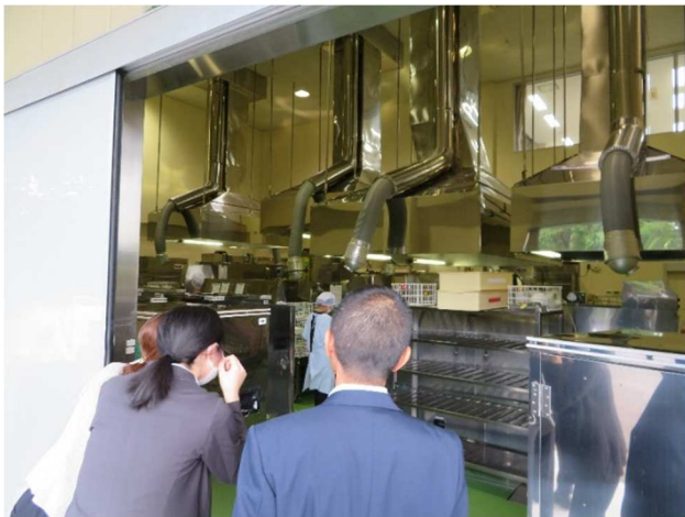
給食調理場内部
