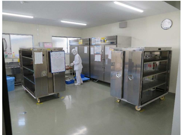
中学校給食保管室
