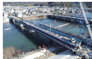
複線化工事(宇治川周辺) (参考) https://www.westjr.co.jp/railroad/project/project3/
