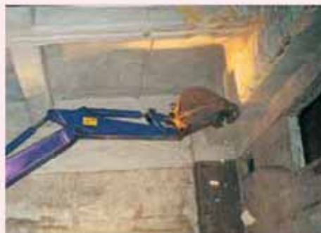
発泡ウレタン断熱材 (吹きつけ)
