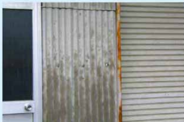
石綿スレート（屋根・外壁）
