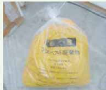
アスベスト廃棄物の二重袋詰
