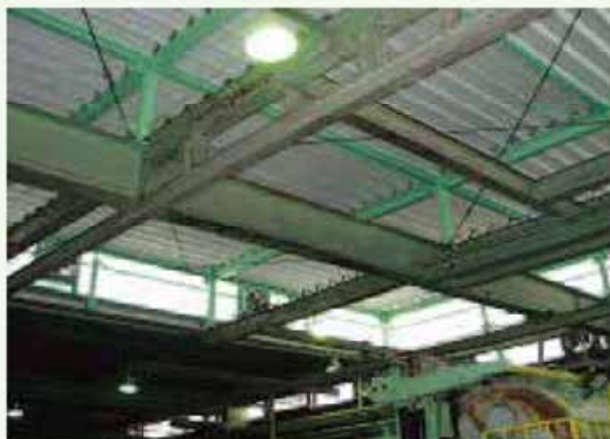
屋根用折版断熱材（折版屋根裏）
