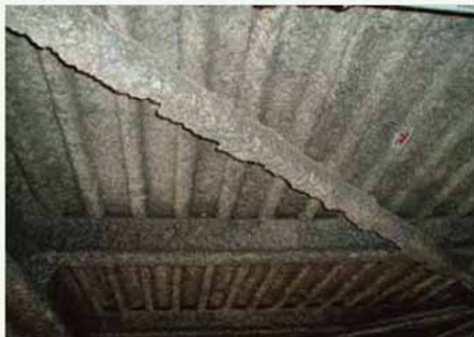
断熱用吹付け石綿・石綿含有吹付けロックウール（折版屋根裏、デッキプレート床裏、階段裏・庇裏等）
