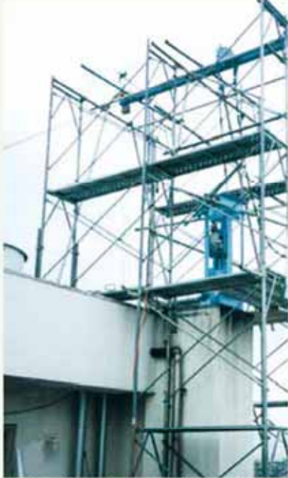
煙突上部及び灰出し口を隔離養生
