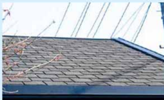
石綿含有住宅化粧用スレート（屋根）
