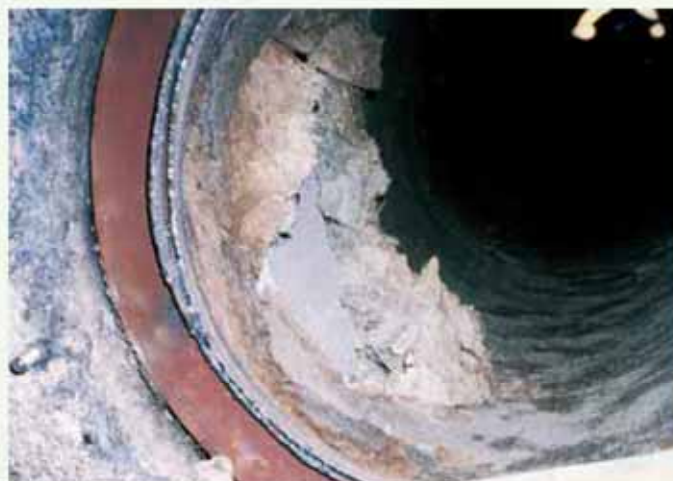
煙突断熱材（ライニング）
