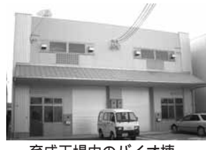
育成工場内のバイオ棟
