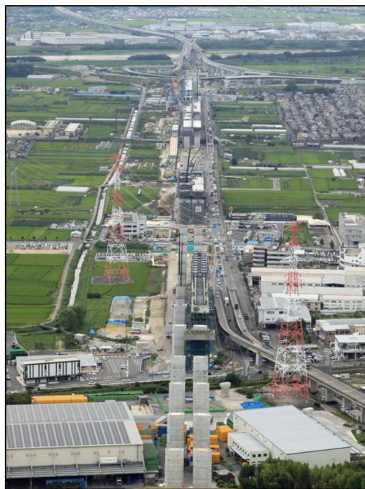
新名神高速道路の整備 (城陽市寺田・国道24号)
