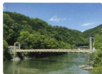
天ヶ瀬吊り橋
