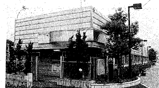
JR木幡駅前の駐輪場
