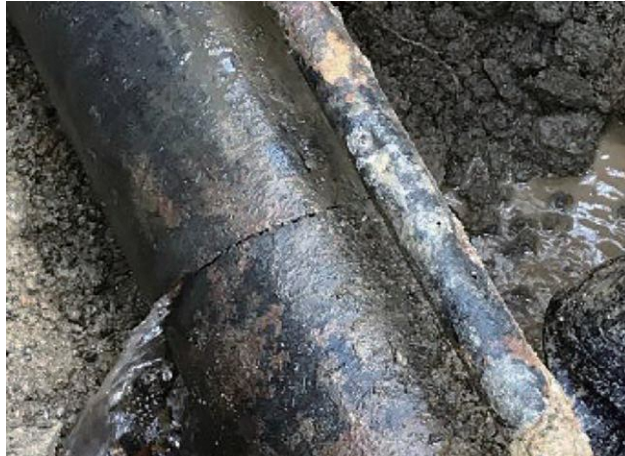
鋳鉄管の漏水
