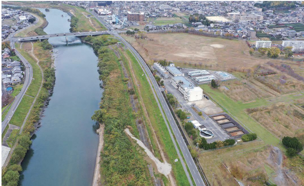
上空から見た宇治浄水場
