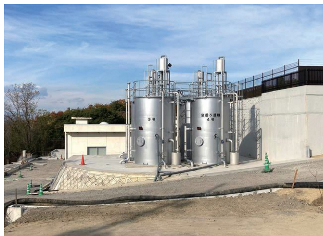
新たな浄水場(広野町浄水場)の整備
