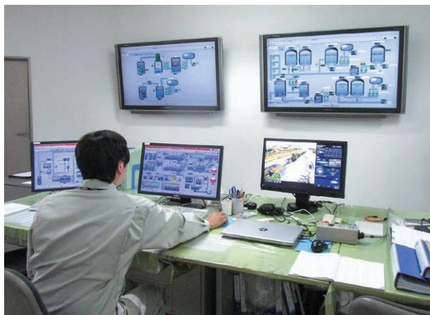
宇治浄水場中央監視室
