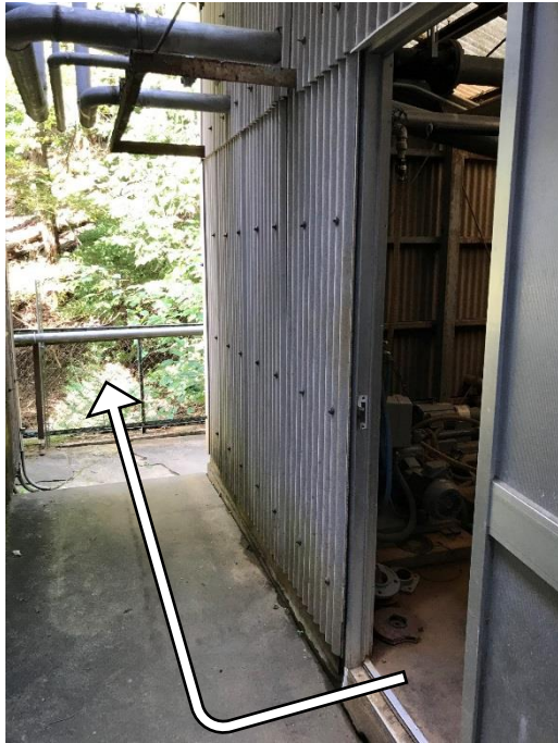
※5 ポンプ室出入り口から河川
