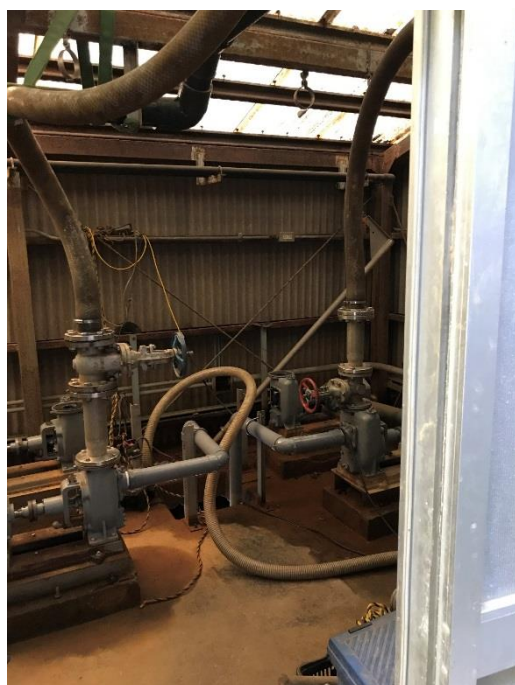
※ 3 ポンプ室出入り口からポンプ室内
