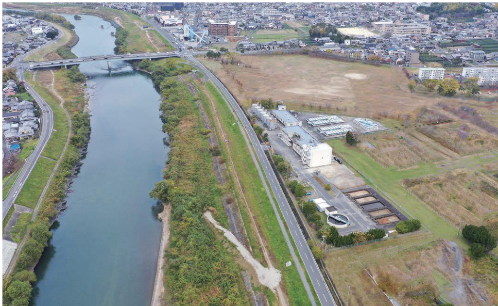
上空から見た宇治浄水場
