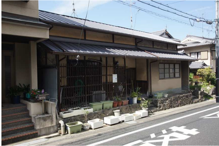
瓦屋根を金属屋根に改修し建物を軽量化
