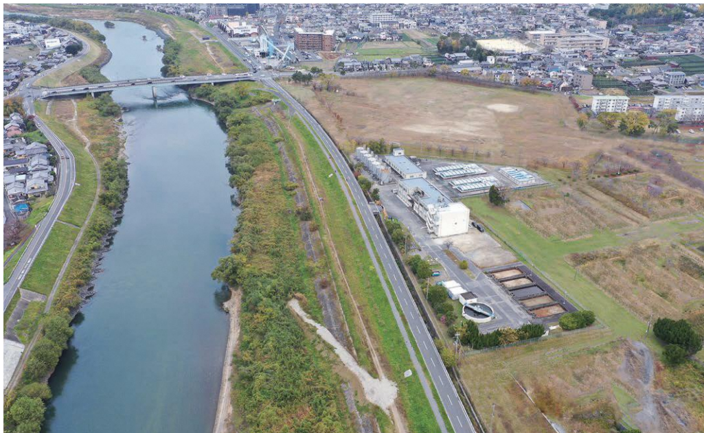
上空から見た宇治浄水場
