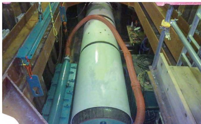
基幹管路の耐震化(シールド工法による施工)
