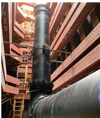
基幹管路の耐震化
