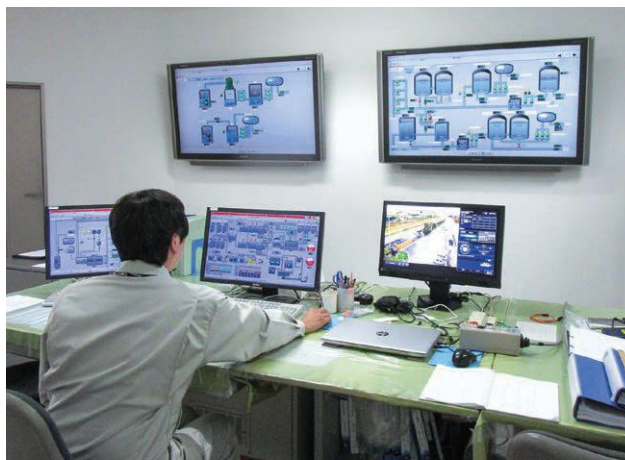
宇治浄水場中央監視室
